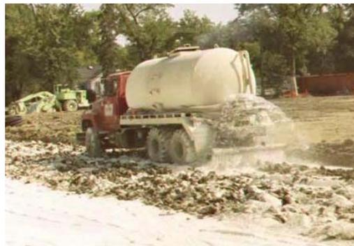
**Figura13: Adición de agua después la aplicación de cal seca<sup>5</sup>**
