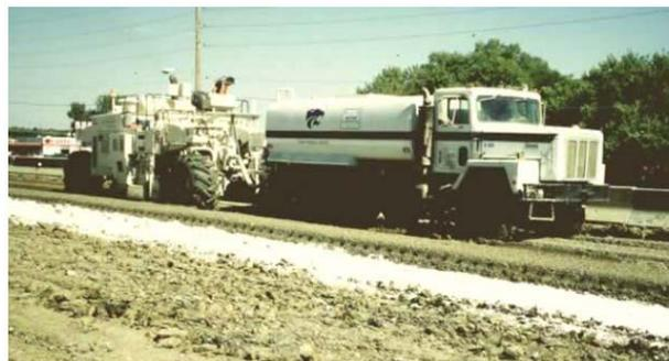
**Figura15: Estabilizadora de suelos con camión de agua.**
