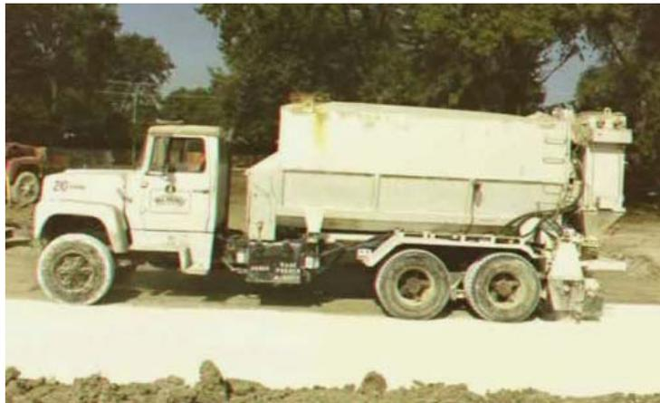
**Figura10: Uso de cal seca con aplicación mecánica<sup>4</sup>.**
