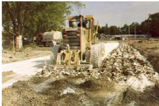
**Figura 12: Escarificación después de extensión de cal.**
